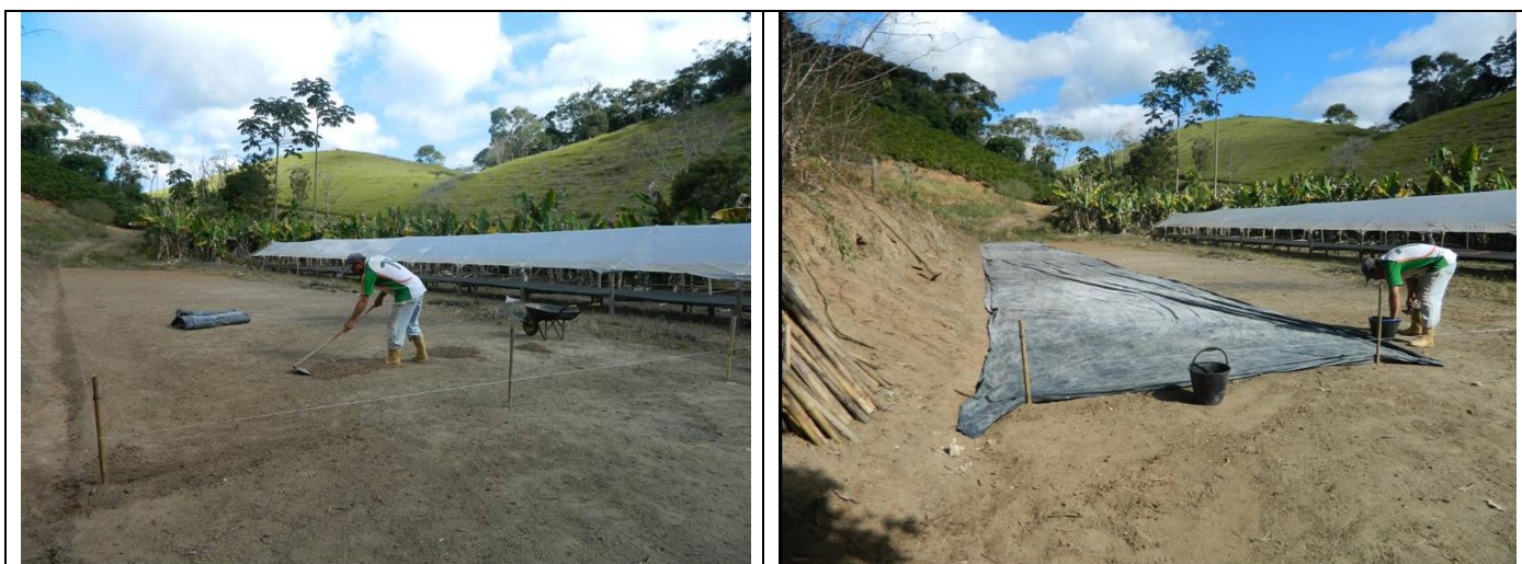
Acertando o terreno (esq.) e instalando a lona plástica sobre o solo (dir. ), para formar a base do terreiro
